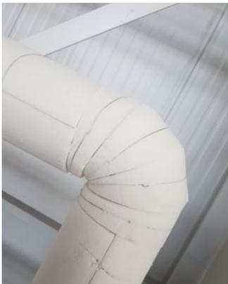
**[ABB. 10]** Bogendämmung aus segmentgeschnittenen PIR-Halbschalen.
