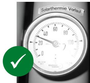
**[ABB. 40]** Thermometer mit geeigneter Abstandshülse verwenden.
