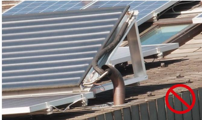
**[ABB. 39]** Das Dämmmaterial sackt nach unten ab. Es besteht die Gefahr, dass Regenwasser in das Umhüllungsrohr eintritt und ins Gebäudeinnere gelangt. Anschlüsse am Kollektor sind nicht gedämmt, Fühlerkabel ist verknäuelst und der UV-Strahlung ausgesetzt.
