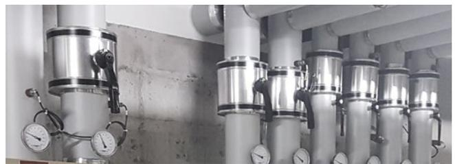
**[ABB. 12]** Die leicht zu demontierenden Armaturenkappen sind wenn möglich auf die Rohrdämmung abzustellen.
