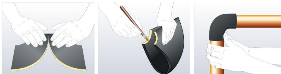
Abb. 24 Dämmung Rohrbogen aus Plattenmaterial am Objekt anbringen
