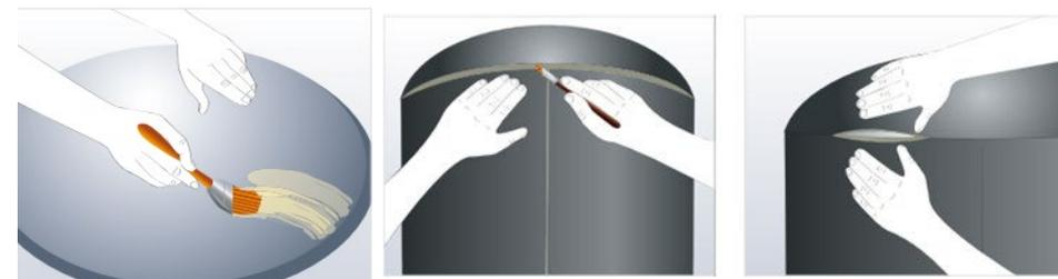
Fig. 46 Pose de l'isolant en plaque sur le dôme d'une cuve
