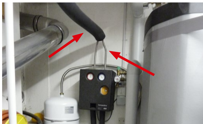
[ABB. 41] Dämmung bis in die Solarstation hineinführen.
