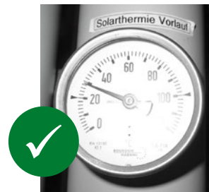
[ABB. 40] Thermometer mit geeigneter Abstandshülse verwenden.
