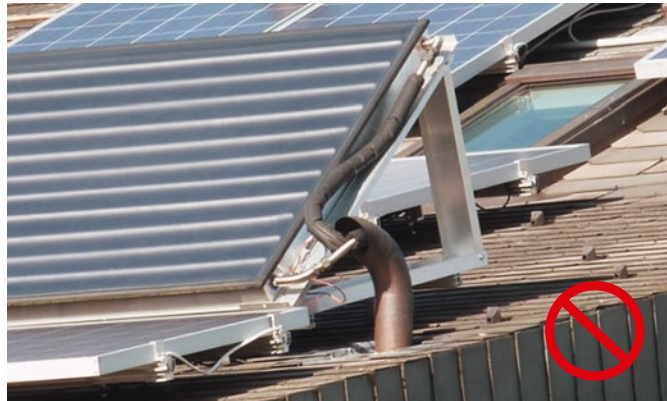
[ABB. 39] Das Dämmmaterial sackt nach unten ab. Es besteht die Gefahr, dass Regenwasser in das Umhüllungsrohr eintritt und ins Gebäudeinnere gelangt. Anschlüsse am Kollektor sind nicht gedämmt, Fühlerkabel ist verknäult und der UV-Strahlung ausgesetzt.
