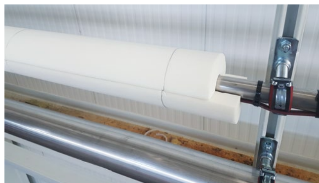
[ABB. 8] Versetzt angeordnete Dämmung mit Kunststoffhalbschalen aus Polyisocyanurat (PIR).
