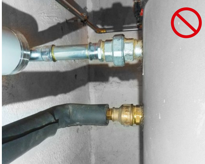
[ABB. 31] Diese Installation zeigt mehrere Nachlässigkeiten gleichzeitig auf: Die Anschlüsse am Warmwasserspeicher sind nicht gedämmt. Die Dämmstärke des synthetischen Kautschuks entspricht nicht den Vorschriften. Die Naht ist nicht richtig verschlossen und sie sollte nicht seitlich, sondern zur Verhinderung der natürlichen Konvektion bevorzugt im unteren Bereich angeordnet sein. An diese Rohrleitung gehört eine klassische Dämmung mit Mineralwolle gemäss kantonalen Energiegesetzen!
