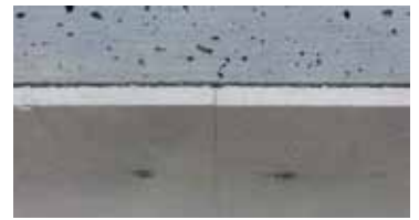
- Renforcement pour protection incendie du béton
