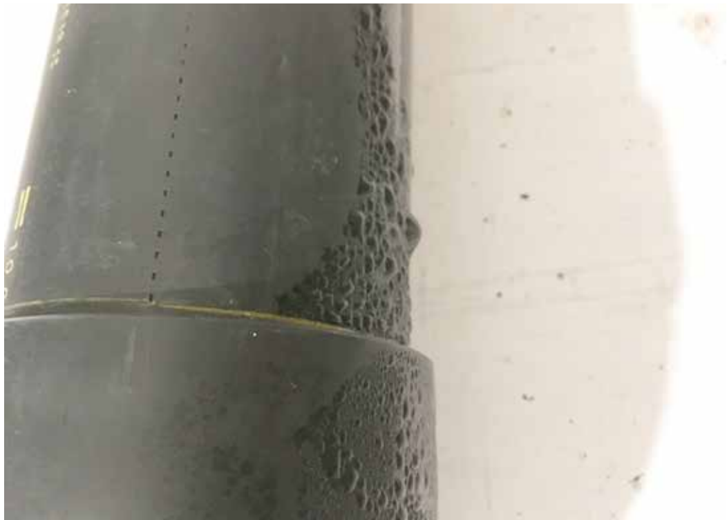
«Les conduites qui transpirent» sont sources d'humidité relative élevée, de corrosion, de moisissures et de pourriture»
