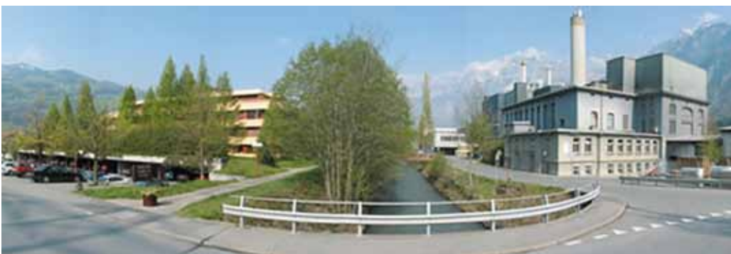
Photo panoramique de Flumroc SA, Flums
